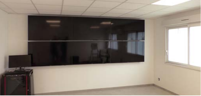
Les travaux des nouveaux locaux de la police municipale de Dourdan en cours d'achèvement.
