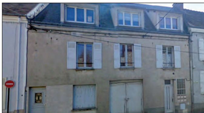
LUCARNES SURDIMENSIONNÉES ET ALTÉRATION DES OUVERTURES D'ORIGINE
