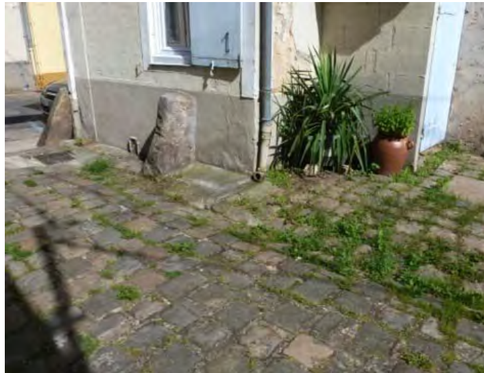
Exemple de pavage traditionnel à joints de terre et pente légère aux abords du bâtiment (revers pavé)
