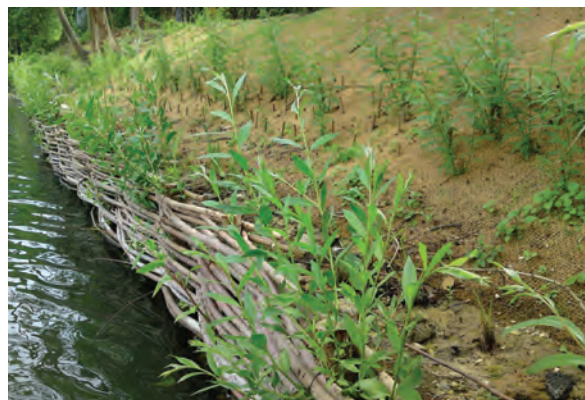
Fascines de saule pour le maintien des berges
