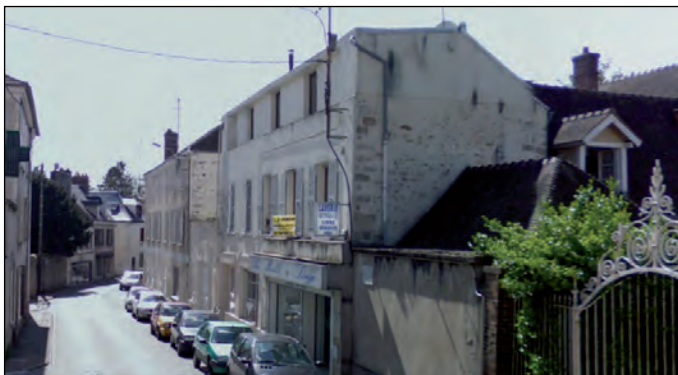
SURÉLÉVATION INADAPTÉE DU BÂTI EXISTANT
