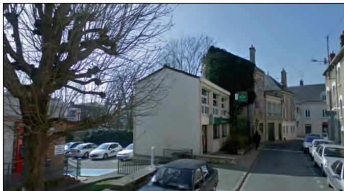
MAUVAISE INSERTION DE NOUVEAU BÂTI
