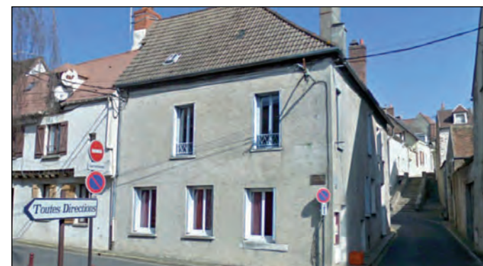
ENDUIT CIMENT ÉLIMINANT LA MODÉNATURE D'ORIGINE
