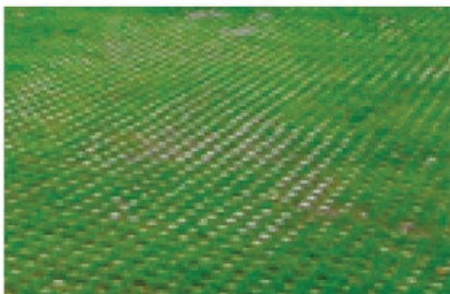
REVÊTEMENT DE TYPE EVERGREEN PERMÉABILITÉ = 70%
