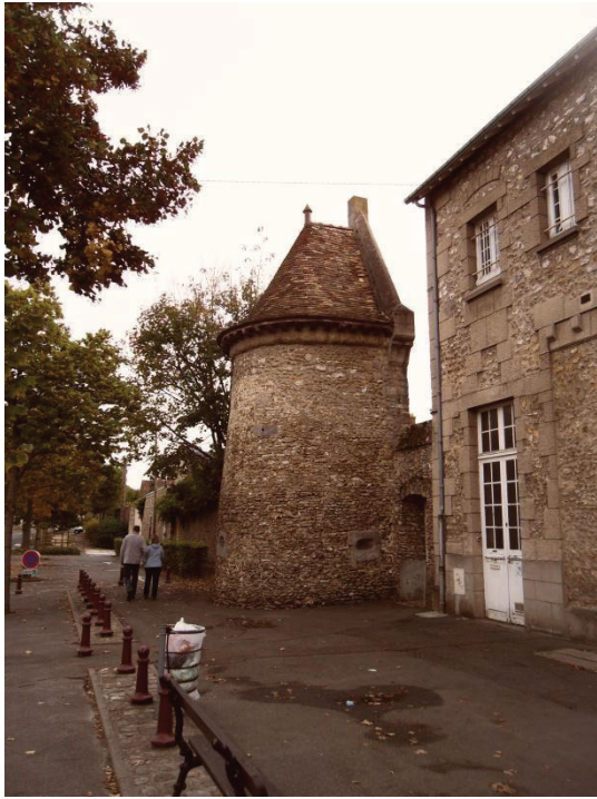
Exemple d'une tour restaurée sur la section d'enceinte située boulevard des Alliés, avec réfection de l'enduit sur moellons, restauration de la toiture en poivrière, etc.....
