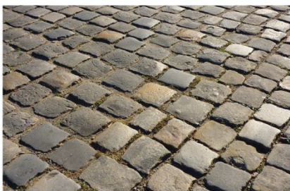
PAVÉ + JOINTS DE TERRE ET CHAUX PERMÉABILITÉ = 30%
