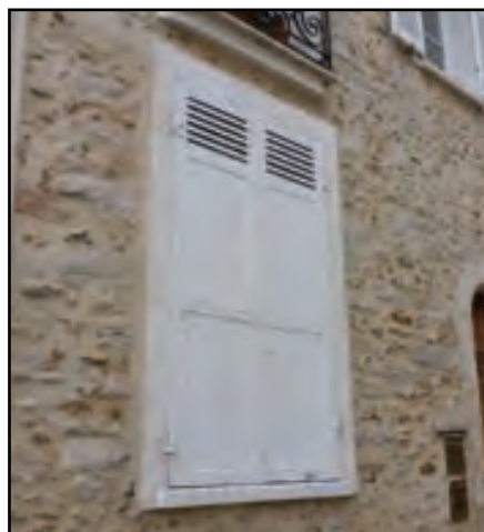
VOLETS BOIS PARTIELLEMENT OU TOTALEMENT PERSIENNÉS (DONT UN RAJOUTÉ SUR UN GARDE-CORPS ANCIEN RÉGIME)
