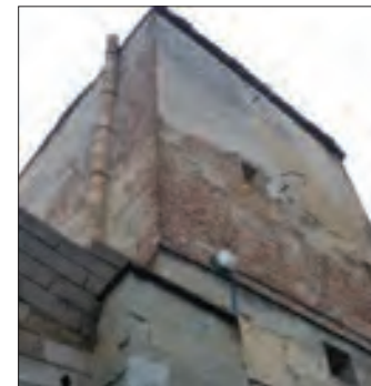
FAÇADE ARRIÈRE EN BRIQUES ALVÉOLAIRES
