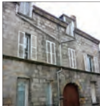
FAÇADE APPAREILLÉE EN GRÈS APPARENT
