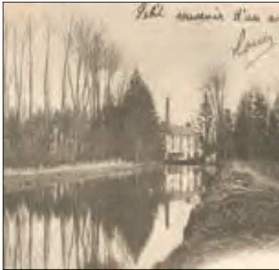
BIEF D'AMENÉE VERS LE GRILLON
