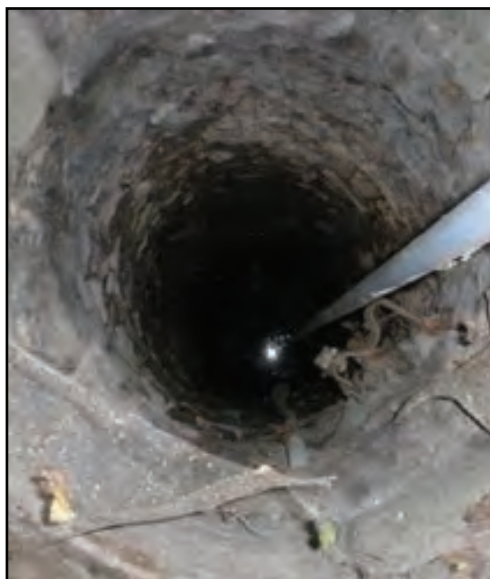
VUE INTÉRIEURE DU PUIITS
