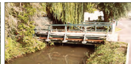
PONT MÉTALLIQUE DE L'ANCIEN MOULIN CHOISELEUR
