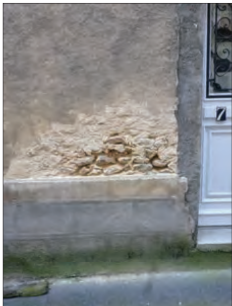
SOUBASSEMENT ET FONDS EN ENDUITS CIMENT
