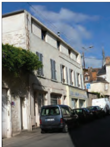
SURÉLÉVATION GLOBALE (RUE D'ÉTAMPES)
