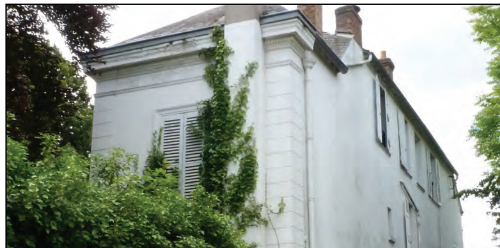
TOITURE INVISIBLE SUR CE BÂTIMENT À R+2
