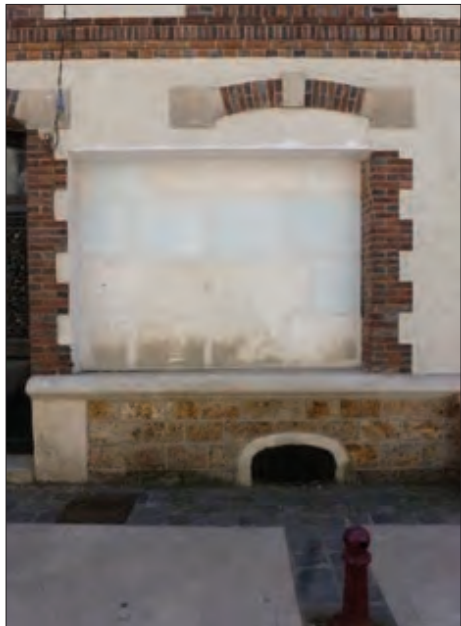
ÉLARGISSEMENT D'UNE BAIE AU RDC
