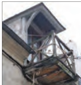
CONSOLES ET BALCONS SUR FAÇADE ENDUITE
