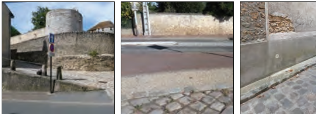
PAVÉS JOINTOYÉS AU CIMENT, BÉTON LAVÉ ET BITUME FORMENT UNE GRANDE PARTIE DES REVÊTEMENTS DE L'ESPACE PUBLIC
