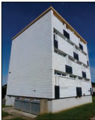
REMPACEMENT D'UNE ANCIENNE ITE SOUS BARDAGE
