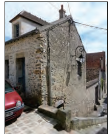
RÉFECTION D'ENDUITS MINCE SUR PIGNON
