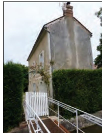
RÉFECTION D'ENDUITS MINCE SUR PIGNON
