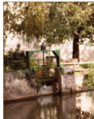
VANNE DE DÉCHARGE
