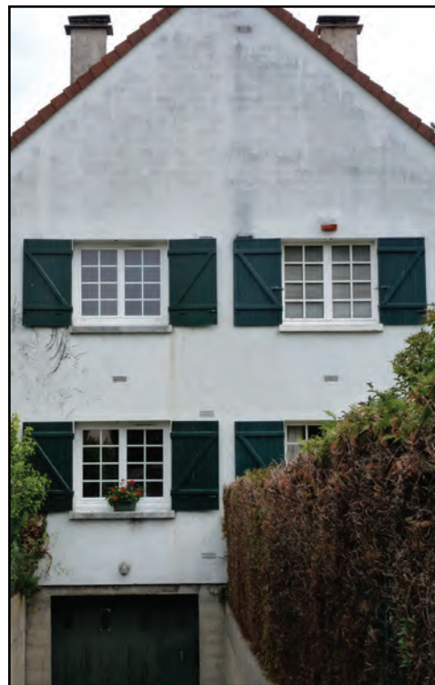
SPECTRES DES MAÇONNERIES EN PARPAINGS ET PLANCHER EN BÉTON ARMÉ — MAISONS INDIVIDUELLES D'APRÈS - GUERRE À DOURDAN
