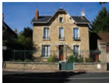
Le grand muret-grille
