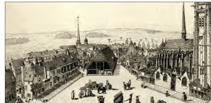
L'ANCIENNE HALLE MÉDIÉVALE
