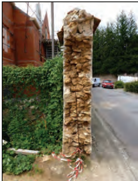
COMPOSITION D'UN MUR DE CLÔTURE TRADITIONNEL: MAÇONNERIE DE CALCAIRE ET SILEX MONTÉES AVEC MORTIER DE CHAUX ET TERRE, ENDUIT À LA CHAUX À PIERRES VUES
