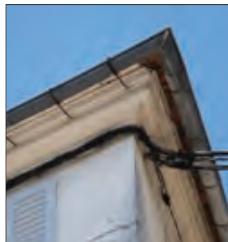
CORNICHE EN PLÂTRE
