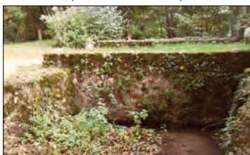
PONT DE LA PROPRIÉTÉ DU GRILLON (ARCHES COMBLÉES)
