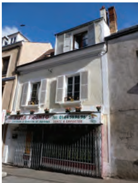
LUCARNE MAÇONNÉE MASSIVE
