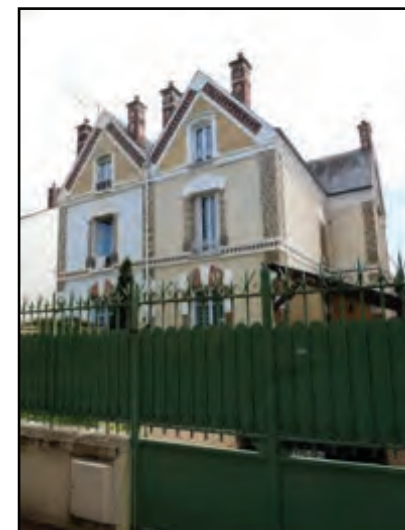
ORNEMENTATION EN PLÂTRE
