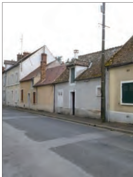
BÂTI RURAL (RUE RAYMOND LAUBIER)
