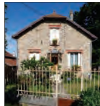
MAÇONNERIES APPARENTES EN PIERRES MEULIÈRES
