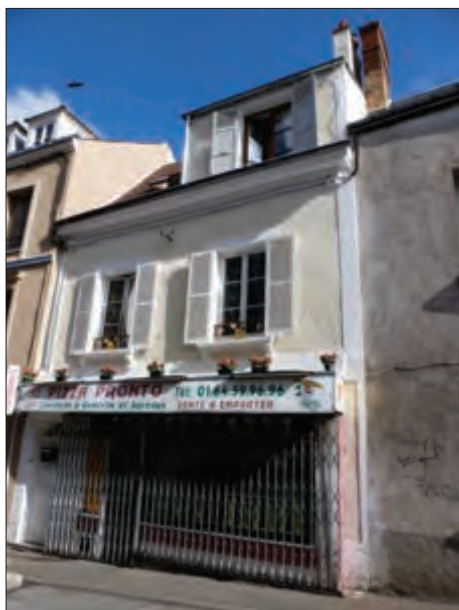
LUCARNES MASSIVES (RUE HAUTE FOULERIE)
