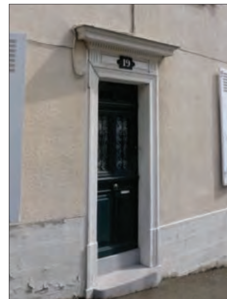
ENDUIT TALOCHÉ RÉCENT AUTOUR D'UN ENCADREMENT DE PORTE CONSERVÉ
