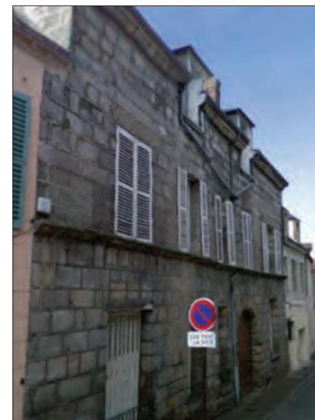
HÔTEL (RUE HAUTE FOULERIE)
