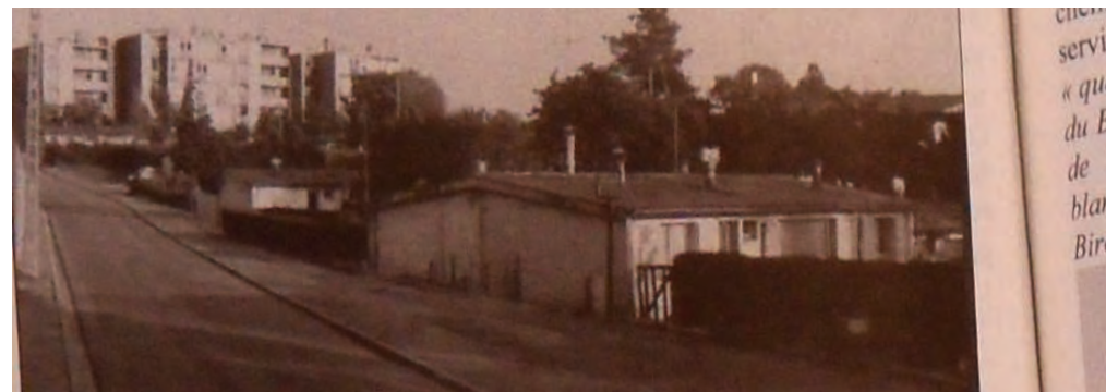
CITÉ D'URGENCE CONSTRUIT EN 1950 RUE PIERRE PAVARD
