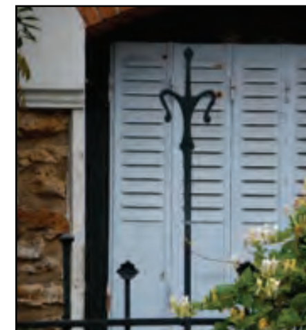
PERSIENNES MÉTALLIQUES REPLIABLES EN TABLEAU (FIN XIX ÈME DÉBUT XX ÈME )
