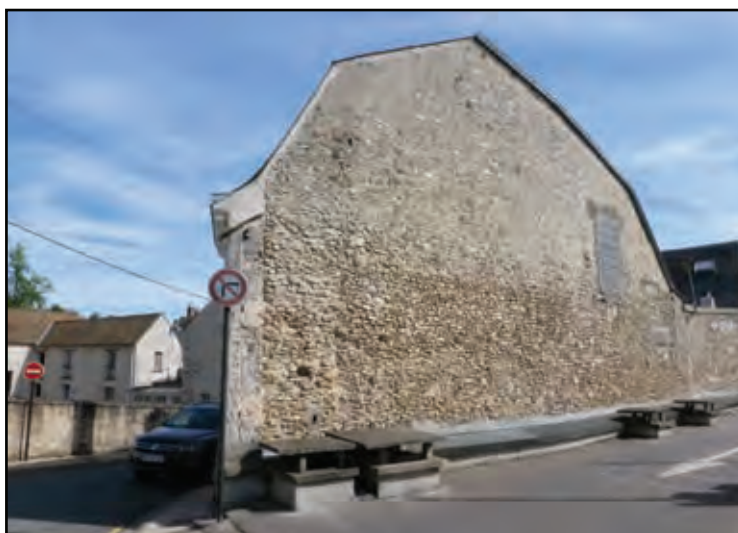
PIGNON EN MAÇONNERIES NON APPAREILLÉES
