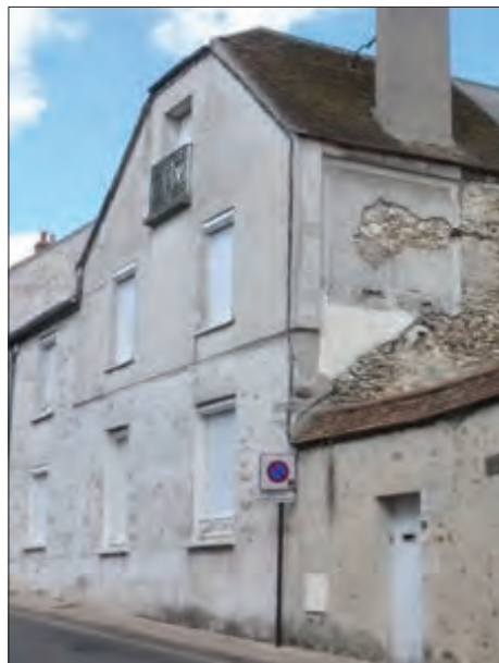
REMPLACEMENT DES VOILETS EXTÉRIEURS PAR DES VOILETS ROULANTS EN PVC
