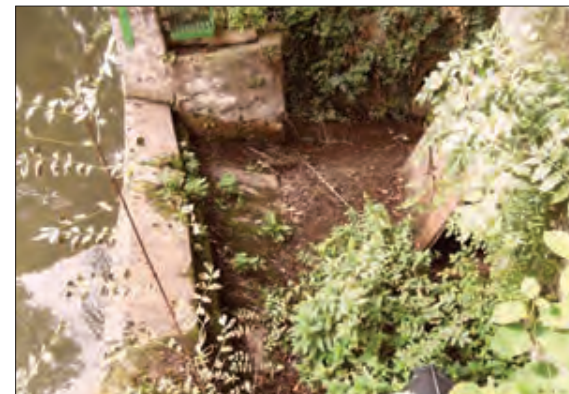
BIEF DE DÉCHARGE ET TROP-PLEIN
