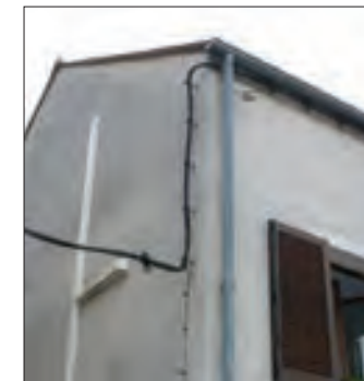
FAÇADE ET PIGNON ENDUIT DE FORME ÉPURÉE
