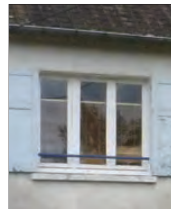
MAINTIEN DES PETITS BOIS EN PAR- TIE HAUTE ET ÉVOLUTION DE LA BAIE QUI TEND VERS LE RECTANGLE PAVILLONS DES ANNÉES 50 /60
