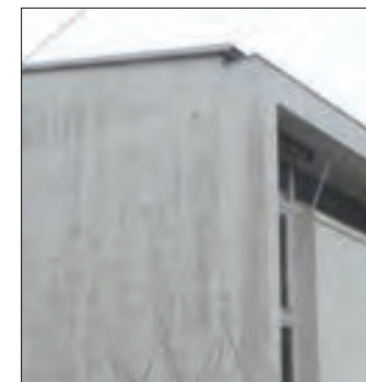
BÂTIMENT NÉO MODERNE DES ANNÉES 80
