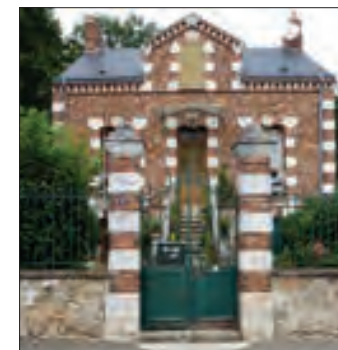
MAÇONNERIES APPARENTES EN ROCAILLAGE FIN
