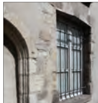
MAÇONNERIES ANCIENNES ET ENDUIT À PIERRE VUE
