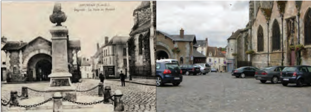
Sur la place du général de Gaulle, les pavés de grès n'ont pas changé depuis le début du XX ème siècle. On remarque la disparition du trottoir et le déplacement du fil d'eau ainsi que la disparition du buste, la diminution de la taille des trottoirs. Les joints en sable ont été remplacé par les joints en ciment. La place a donc gardé sa structure d'origine, ainsi que son matériau de revêtement de sol.
