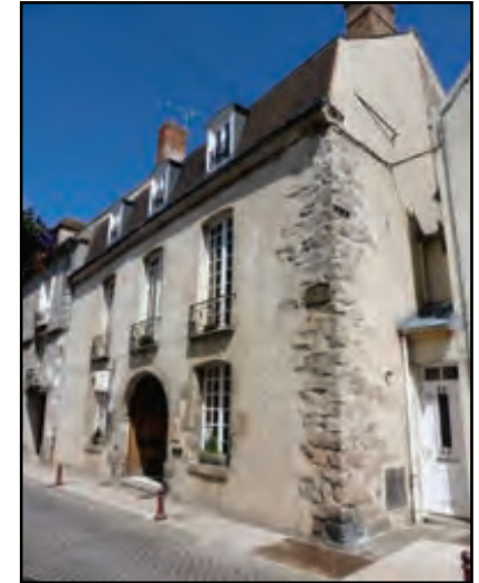
RÉFECTION D'ENDUITS À PIERRES VUES
