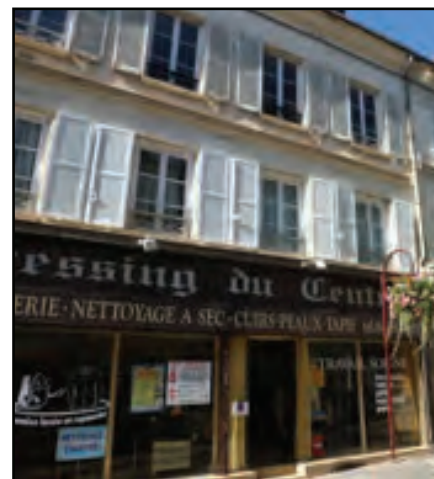
PERSIENNES BOIS ET GARDE-CORPS DANS LE TABLEAU SUR CETTE FAÇADE DU DÉBUT XIX ÈME
